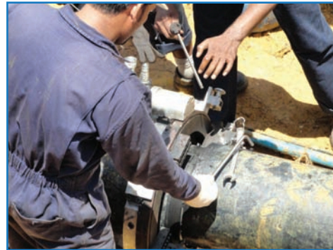
Uso de DLW en sitio con gasoducto
