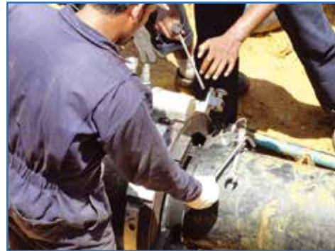
Uso de DLW en sitio con gasoducto
