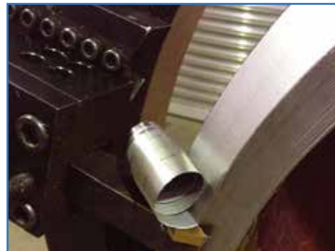
Alta eliminación de metal en P91 tubo
